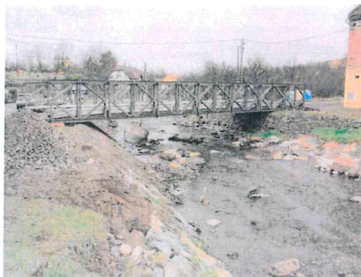
Pohled na mostní provizorium z pravé strany (návodní)
